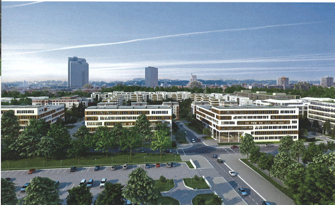
FOTO: HUBERT HAUPT IMMOBILIENHOLDING
