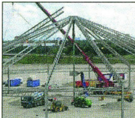
Hier entsteht die Zelt-Stadt
